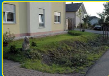
Cuvette d'infiltration et rigole en bord de route
