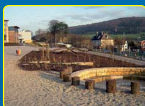
Cour de récréation perméable à l'eau à Roodt/Syre
