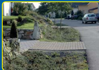
Fossé d'infiltration en bord de route
