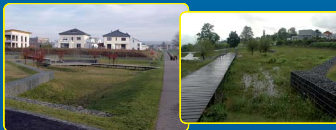
Infiltration centralisée avec surface de rétention (état sec et rempli)
