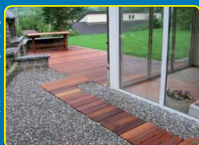
Terrasse en graviers avec caillottes en bois
