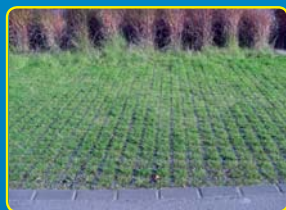
parking perméable à Beckerich
